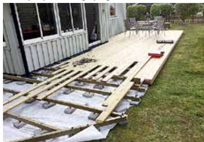
Exempel på montage på gräsmatta med fiberduk
