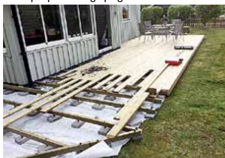
Exempel på montage på gräsmatta med fiberduk
